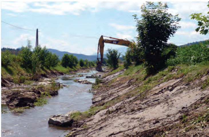
Abb. 12: Regelmäßige und rechtzeitige Gewässerpflege ist eine wichtige Schutzmaßnahme im Rahmen des integralen Hochwasserrisikomanagements.
