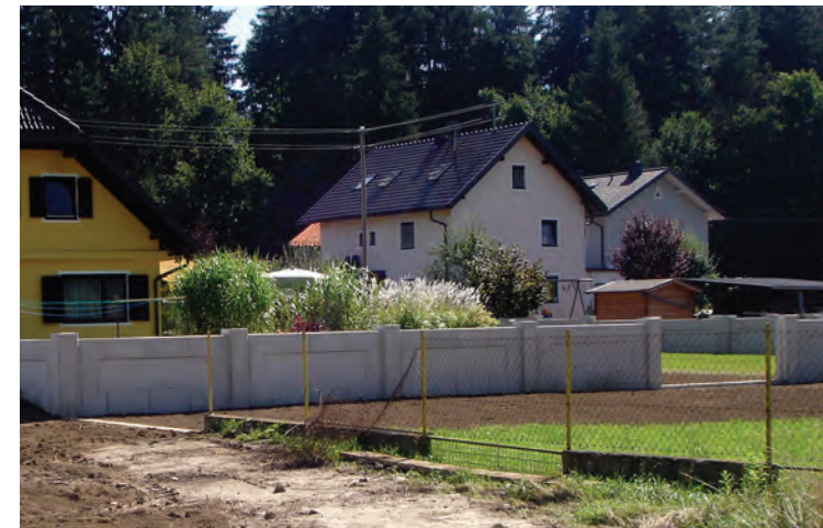
Abb. 11: Beispiel einer privaten Objektschutzmaßnahme. Im Anlassfall setzen die Anrainer mobile Einschubelemente in die Aussparungen der Schutzmauer.
